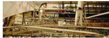
En étroite collaboration avec les acousticiens et les architectes, les staffeurs ont d'abord tracé un axe central reliant le fond de la salle à l'arrière-scène. Puis, mètre par mètre, la courbe a été calculée en fonction de la réverbération sonore souhaitée et réalisée symétriquement, d'un côté puis de l'autre de l'axe tracé.
