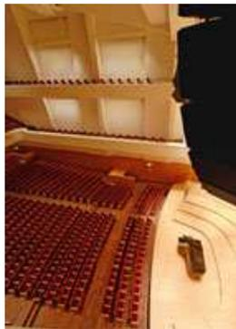
Le fond de la salle est quant à lui avancé afin de réduire le volume de la salle et de supprimer les sièges pour lesquels les conditions d'écoute n'étaient pas satisfaisantes. Des balcons latéraux sont aussi ajoutés afin d'améliorer l'acoustique. Revêtus de plaques de plâtres, ils permettent de projeter les réflexions sonores sur le parterre, de clarifier le son et de créer une sensation d'enveloppement sonore.
