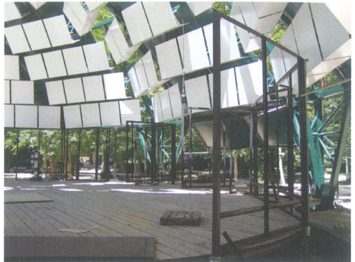
Vue du montage des réflecteurs acoustiques - Photo Europodium
